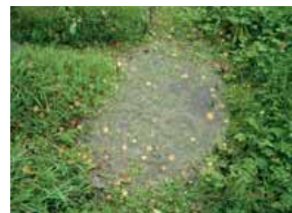
Abb. 31: Gelegenheit Vernässung: defekte Drainage in Brislach.
