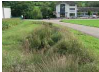
Abb. 35: Gelegenheit Erschliessungsstrasse: neuer Graben in Thürnen.
