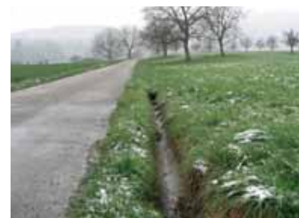
Abb. 32: Gelegenheit Grabensanierung, Ersatz von Halbröhren (Biel-Benken).
