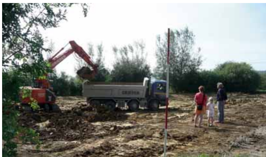
Abb. 68: Während den Bauarbeiten muss die Projektleitung regelmässig anwesend sein. Ausserdem ist die Information der Bevölkerung wichtig (Foto: Werner Götz).
