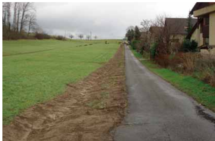
Abb. 90: Öffnung Drainage «Eigen-Wiese». Aus einer defekten Drainageleitung trat Wasser an die Oberfläche und behinderte die Bewirtschaftung. Statt die Drainageröhren zu ersetzen, konnte die Sanierung mit der Offenlegung als flacher Graben verbunden werden. Um die Bewirtschaftung nicht zu behindern, wurde der Graben von der Grundstücksmitte an den Fahrweg verlegt. Obwohl eine Gasleitung überquert werden musste, war die Öffnung kostengünstiger als der Ersatz der Drainageleitung. Kosten: Fr. 15'000 für 200 m Offenlegung (Fr. 75/ Laufmeter). Foto: Daniel Niederhauser).
