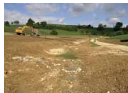
Abb. 82: Im April 2007 wurde der noch eingedolte Teil des Hintereggbächlis auf einer Länge von 181 m renaturiert. Die Kosten belaufen sich auf 29'500 Franken (Fr. 160 / Laufmeter). Davon entfällt aber rund ein Drittel (Fr. 10'300) auf die Unterquerung eines Feldwegs (Foto: Urs Chrétien).
