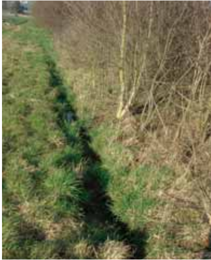
Abb. 89: Als Ersatz für defekte Drainageröhren bietet sich, falls die Bewirtschaftung nicht behindert wird, die kostengünstigere Offenlegung als Gräben an (Foto: Daniel Niederhauser).
