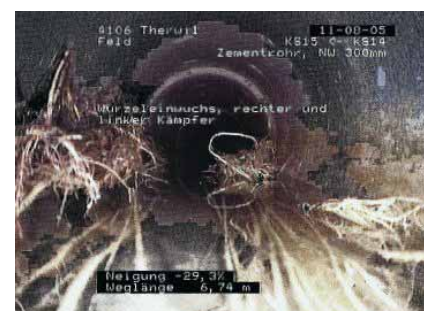
Abb. 88: Die Kanalkamera zeigt ein düsteres Bild der Therwiler Drainagen (Foto: Gemeinde Therwil).
