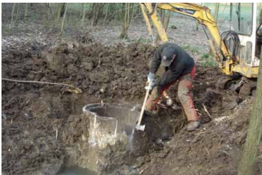
Abb. 91: Im Gebiet Chäppeli befindet sich eine Waldquelle, die 1928 im Rahmen der Felderregulierung drainiert wurde. Durch die defekte Drainageröhre dringt das Quellwasser heute an mehreren Stellen aus dem Boden und hat Vernässungsstellen geschaffen, die von vielen Fröschen und Libellen besiedelt sind. 2008 wurde die Drainage auf der Waldparzelle, die sich im Eigentum der Gemeinde befindet, geöffnet. Durch das Entfernen der Rohre soll wieder eine Quelle entstehen, die sich selbst entwickeln kann. Die Auslichtung des Waldes im Rahmen der Durchforstungsarbeiten der Forstequipe Angenstein wertet die Waldquelle zusätzlich auf. Kosten: 8000 Franken (Foto: Daniel Niederhauser).
